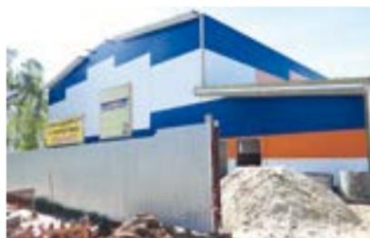
Подрядчики используют современную быстровозводимую технологию строительства — каркасно-панельную. Здание получается теплым, легким и недорогим. Спустя 25-30 лет сэндвич-панели можно будет заменить, при этом каркас останется. А вот если бы здание делали полностью из кирпича, то в случае реконструкции пришлось бы ломать всю конструкцию.
